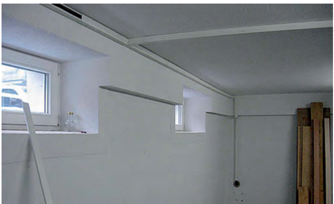
Risvolto della coibentazione sulle pareti verso gli ambienti freddi.
