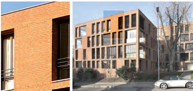
Corrette aperture di ventilazione di intercapedine aerata per rivestimento in mattoni faccia vista. Architetti Baumschlager und Eberle.
