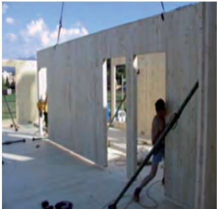
Posa in opera delle pareti
