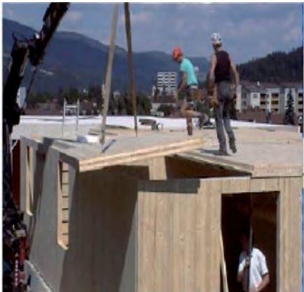
Posa in opera dei solai
