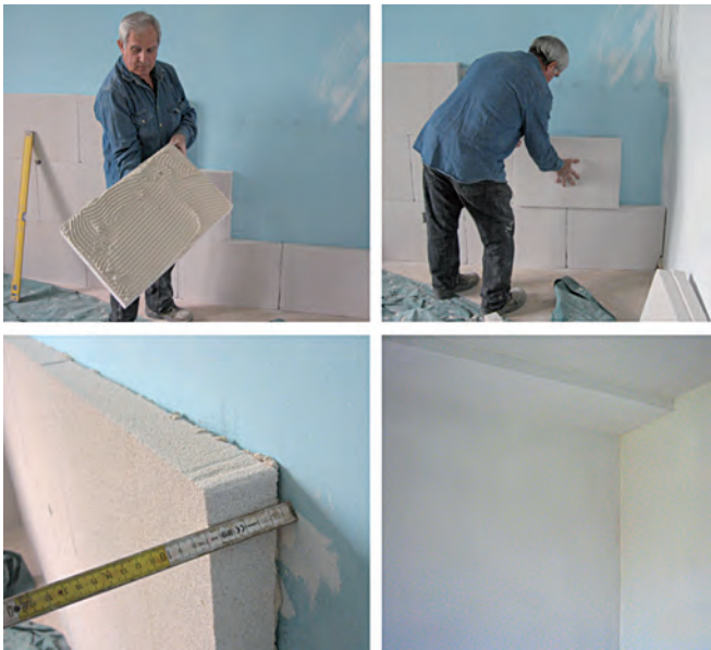
Posa di coibentazione interna in pannelli di idrati di silicato di calcio senza barriera al vapore. Risolto a soffitto per attenuazione ponte termico
