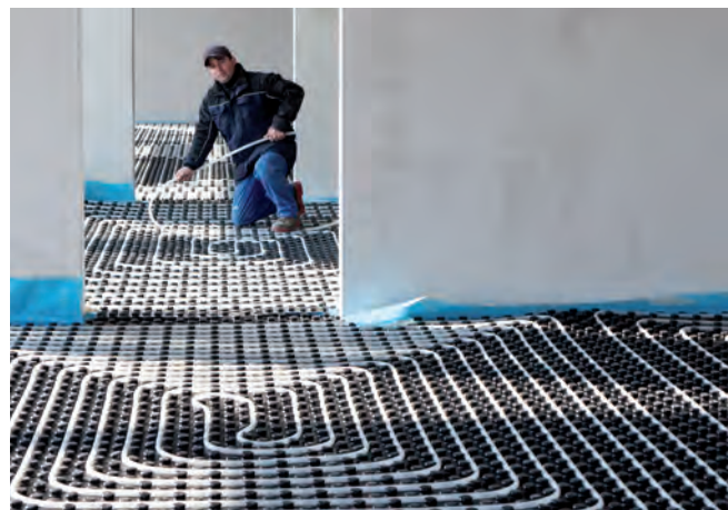
Posa di un pavimento radiante
