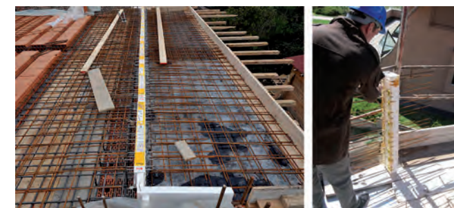
Disgiuntori termici per l'esecuzione di un aggetto.
